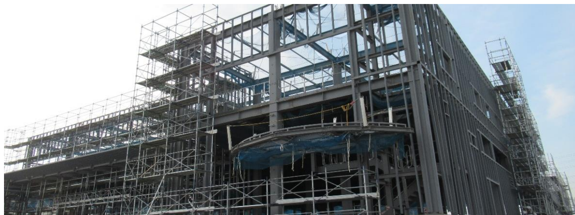
正面玄関（建設中）
